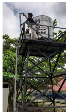
Gambar 5. Pemasangan Pipa Udara
