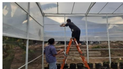
Gambar 3. Instalasi pemasangan alat penyiram
