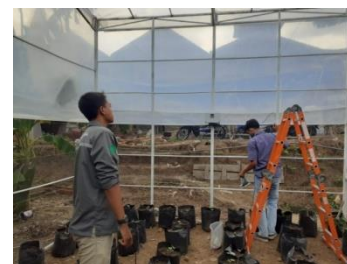
Gambar 5. Instalasi pemasangan alat monitoring suhu
