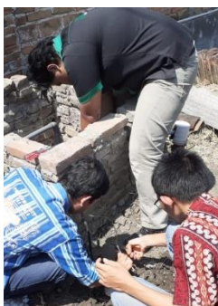
Gambar 1. Pengecekan Kondisi Pompa Air
