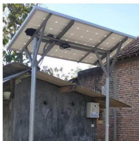
Gambar 3. Pemasangan Panel Surya
