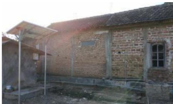
Gambar 5. Pemasangan Alat Keseluruhan
