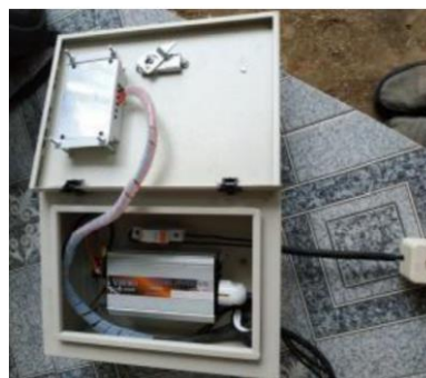
Gambar 2. Pembuatan Panel ATS
