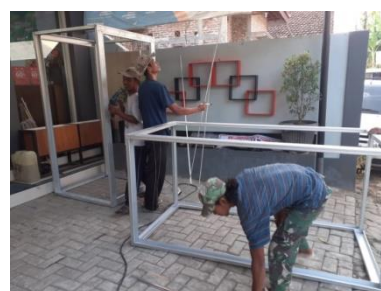
Gambar 2. Pembuatan Kerangka Bilik Disinfektan
