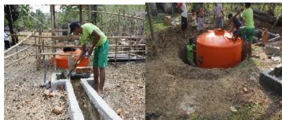
Gambar 4. Pengolahan limbah bio atau biomassa menggunakan digester
