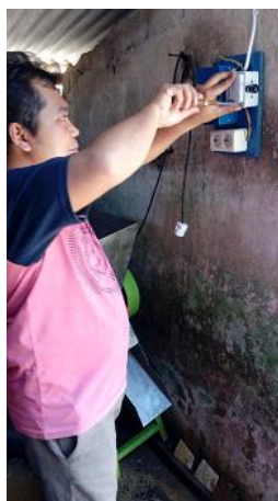
Gambar 3. Proses pemasangan (Sumber: Dokumentasi Kegiatan)
