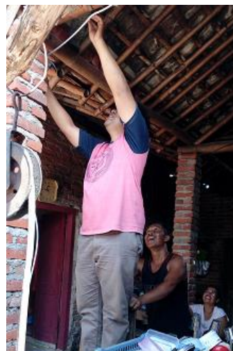
Gambar 4. Pemasangan dan penataan kabel listrik (Sumber: Dokumentasi Kegiatan)
